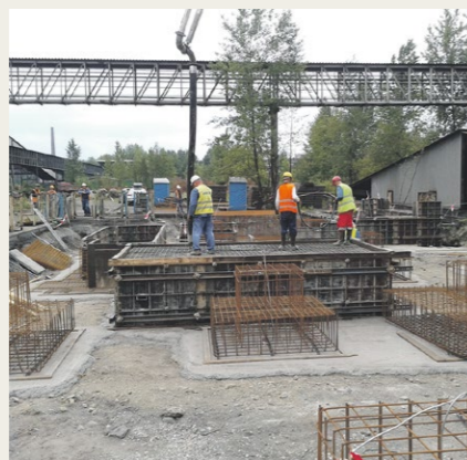
Práce probíhají i na jižní části aglomerace, která dostane nový tkaninový filtr. Tato nejlepší odprašovací technologie od roku 2011 funguje již na severní části
